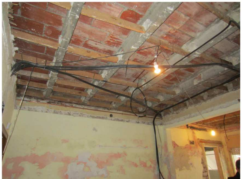
Menjador. Hem tret el cel ras i descobrim l'estructura existent; en el nou cel ras podrem encastar l'il·luminació.
