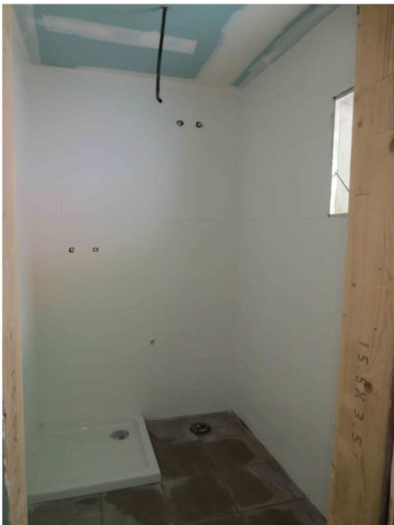
Lavabo. Està col·locat el revestiment ceràmic; el mes següent col·locarem l'equipament.
